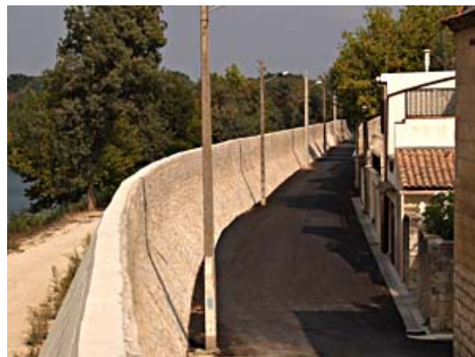
Digue rehaussée en 2006
