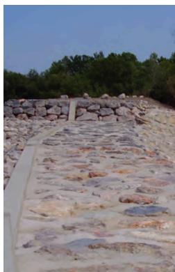
Déversoir de COMPS
